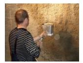
Ob per Hand oder mit der Verputzhilfe geputzt, nach dem Auftragen wird der Lehmputz mit einer Kartätsche abgezogen und nach den Maurerregeln weitergearbeitet. In der Regel erfolgt ein Feinputz.
