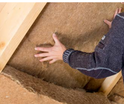
Bei Dämmstärken über 22 cm wird THERMO JUTE 100 zweilagig eingebaut.
