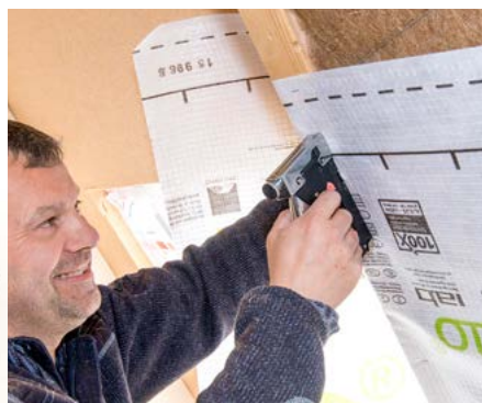
Wichtig ist der fachgerechte Einbau der Luftdichtungsbahnen.
